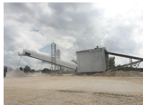
รูปที่ 2-22: การปิดคลุมอาคารโรงโม่
