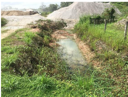
รูปที่ 2-27: คูระบายน้ำรอบโรงโม่หิน
